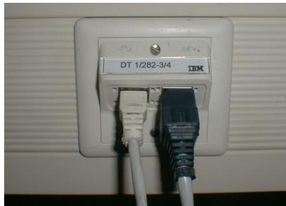
Abbildung 1.4-4.: Zwei Kabel an einer Dose.
